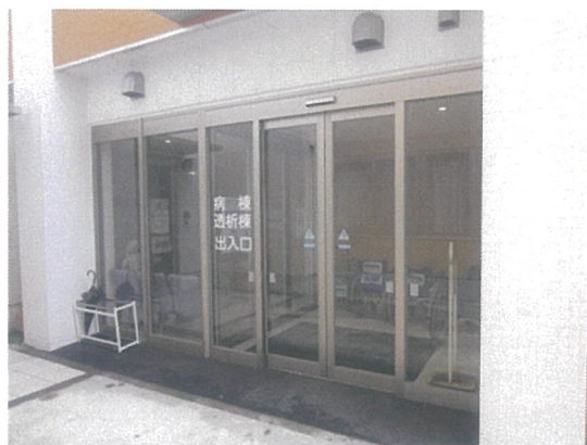
病棟・透析棟入口
